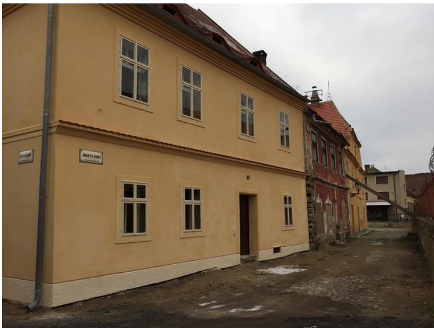
Obrázek 12. Budovy ve vlastnictví Žateckého pivovaru (zleva): budova v rekonstrukci J. Hory 84, prázdná budova J. Hory 639, rekonstruovaná budova J. Hory 85 - Muzeum pivovarnictví Žatecka
