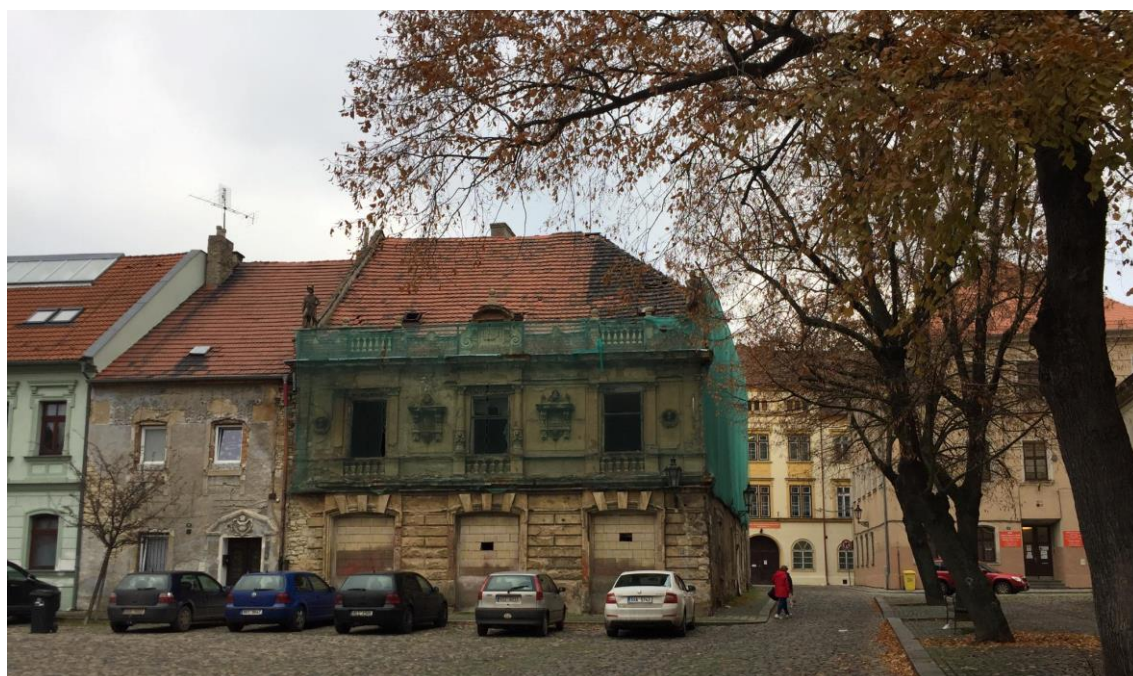
Obrázek 10. Prázdná budova, J. Hory 92
