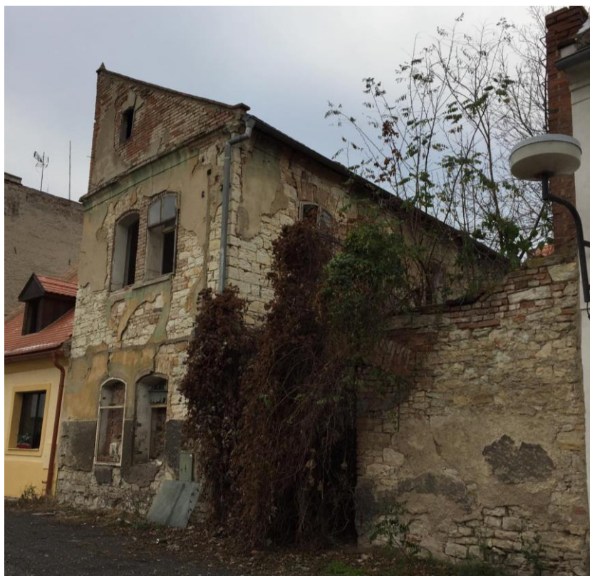
Obrázek 11. Prázdná budova, zadní část budovy Žižkovo náměstí 88, pohled z ulice J. Hory
