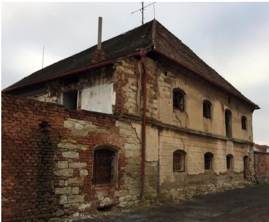
Obrázek 13. Prázdná budova, Žižkovo náměstí 83 – určená k demolici
