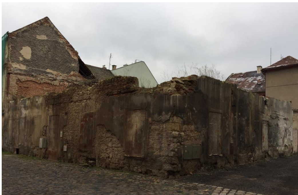
Obrázek 9. Prázdná budova, J. Hory 93
