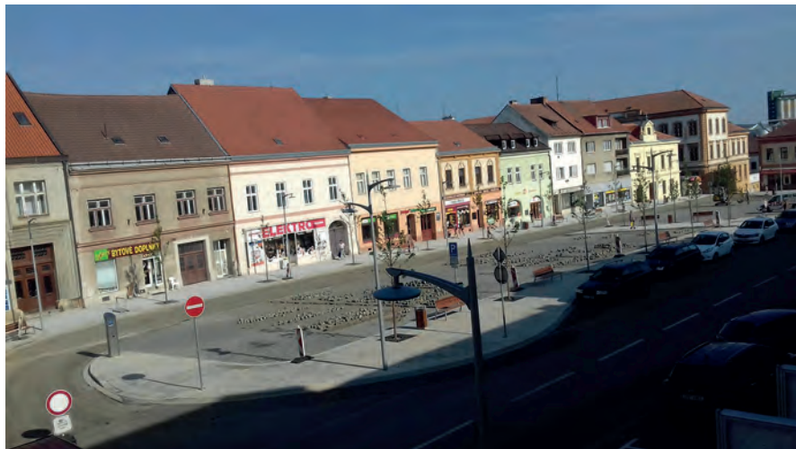
Obrázek č. 11 Náměstí Míru: rekonstrukce
