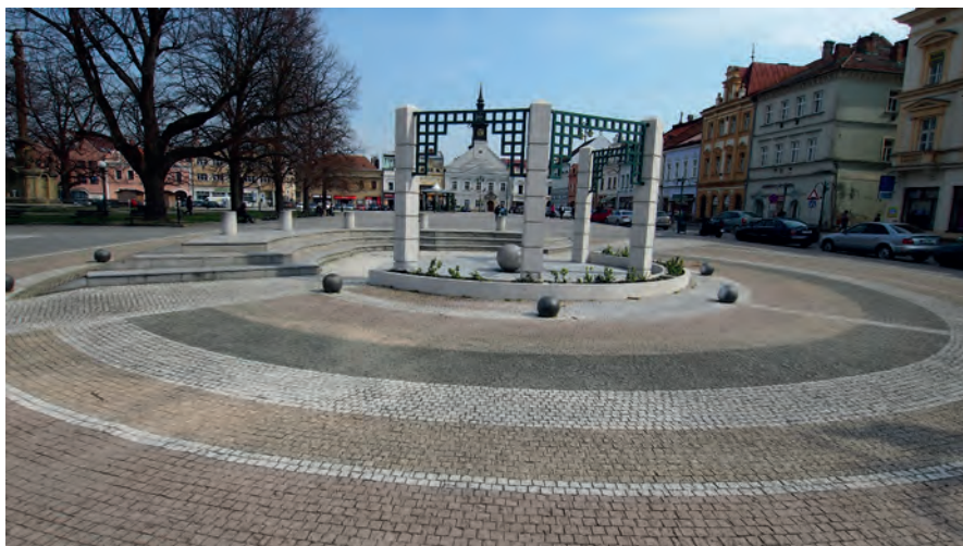
Obrázek č. 46 Náměstí Přemysla Otakara II. ve Vysokém Mýtě: fontána po rekonstrukci
